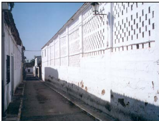
vivienda en almacenamiento agrícola (secadero)
